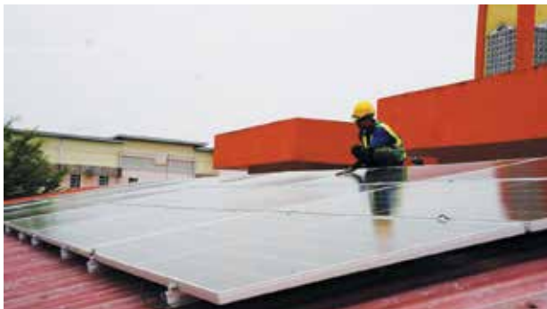
Pemasangan sistem solar PV di atas bumbung Masjid Nurul Iman, Nibong, Pulau Pinang (2023).
